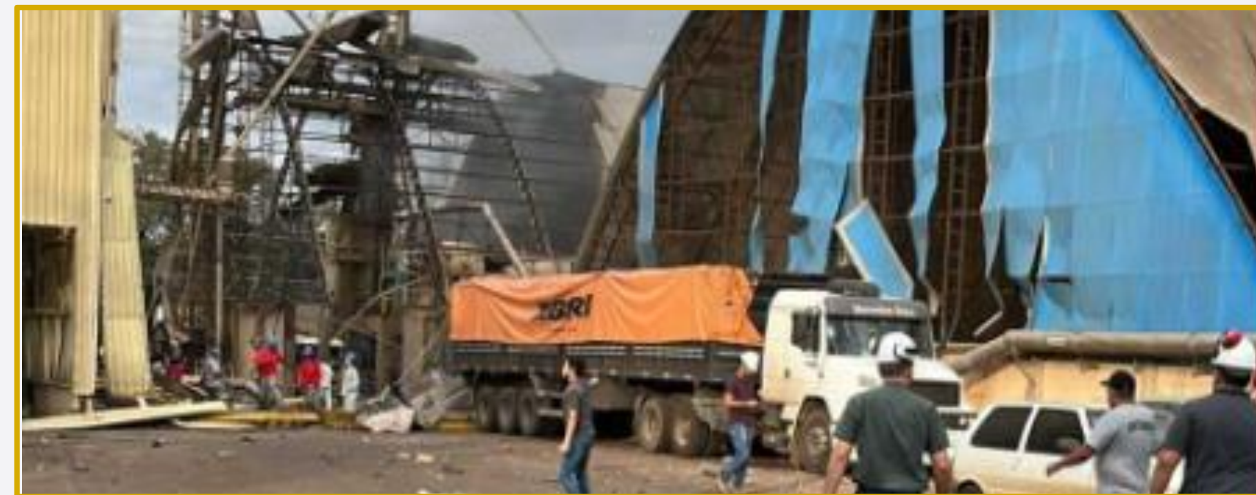
Explosão no armazém da cooperativa de grãos em Palotina – PR, 2023.
