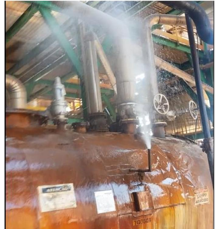
Saída de vapor pela válvula de alívio em um tanque de condensado **PRESSURIZADO sem Equalização**
