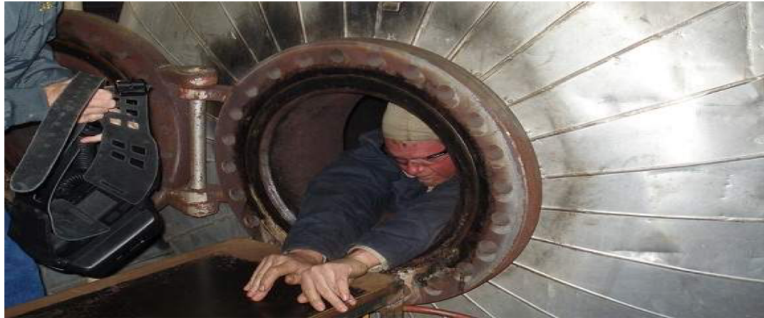
Porta de evaporador, espaço pequeno e de difícil acesso.
