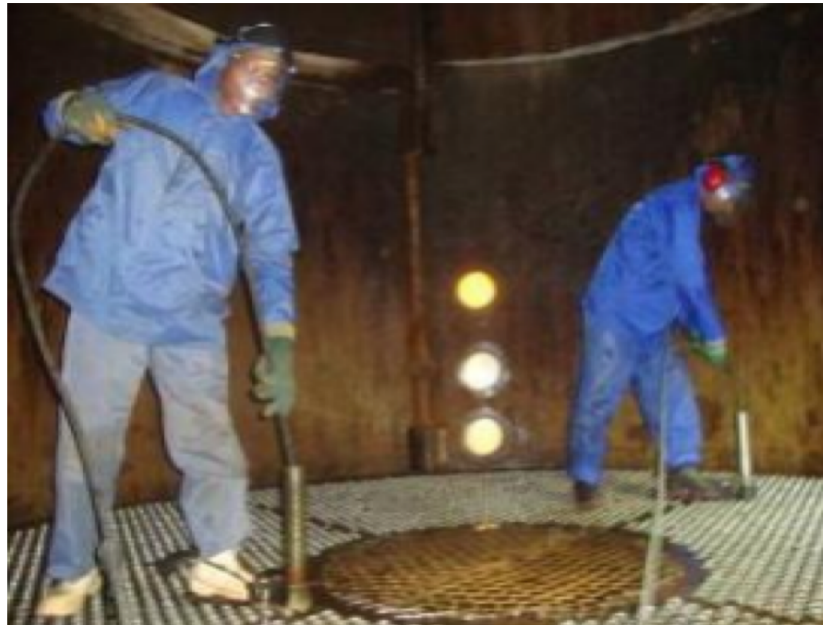
Limpeza com hidrojato.
