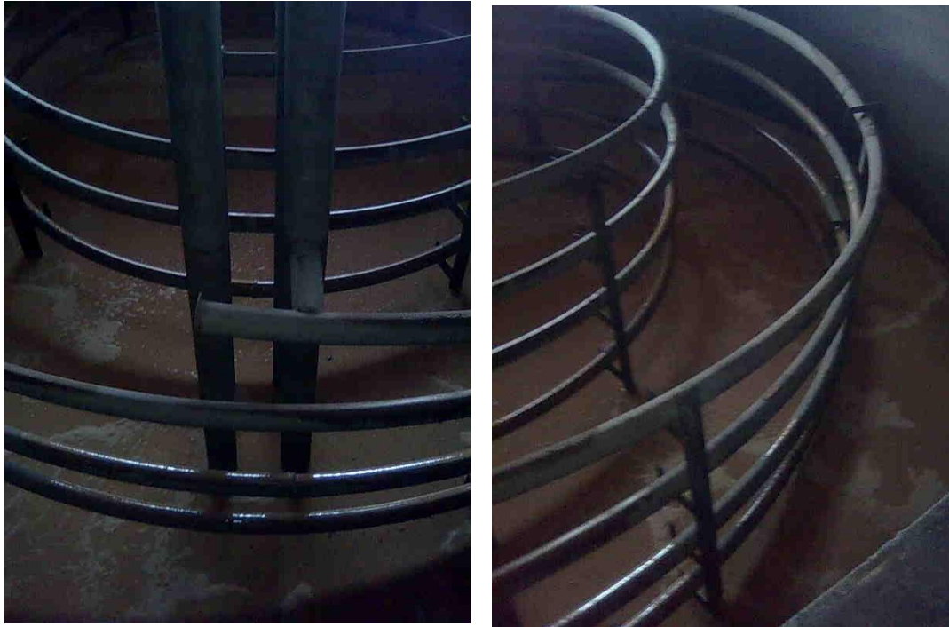
Serpentina dentro da dorna para resfriamento do mosto em fermentação
