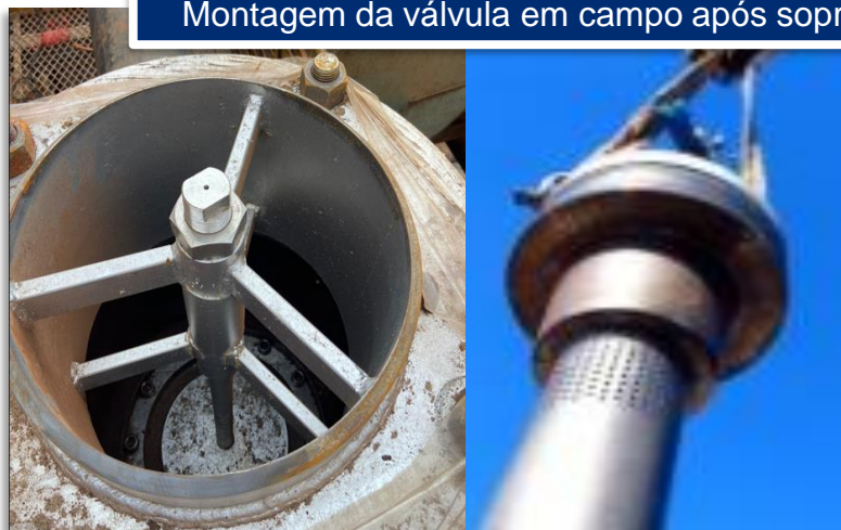
Montagem da válvula em campo após sopragem
