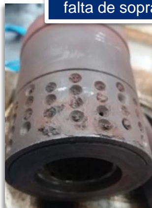
Possíveis consequência da falta de sopragem da linha
