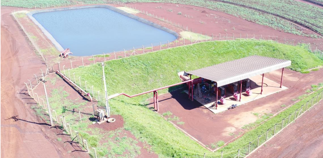
Reserva de Água 5.000m 3 e Bombeamento - S.P.C.I.
