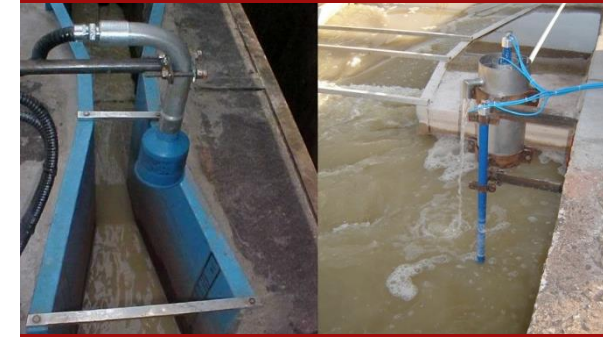
▪ Calha Parshal e vaso coletor
