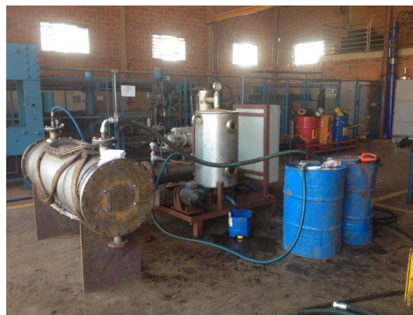
FASE DO “FLUSHING”
