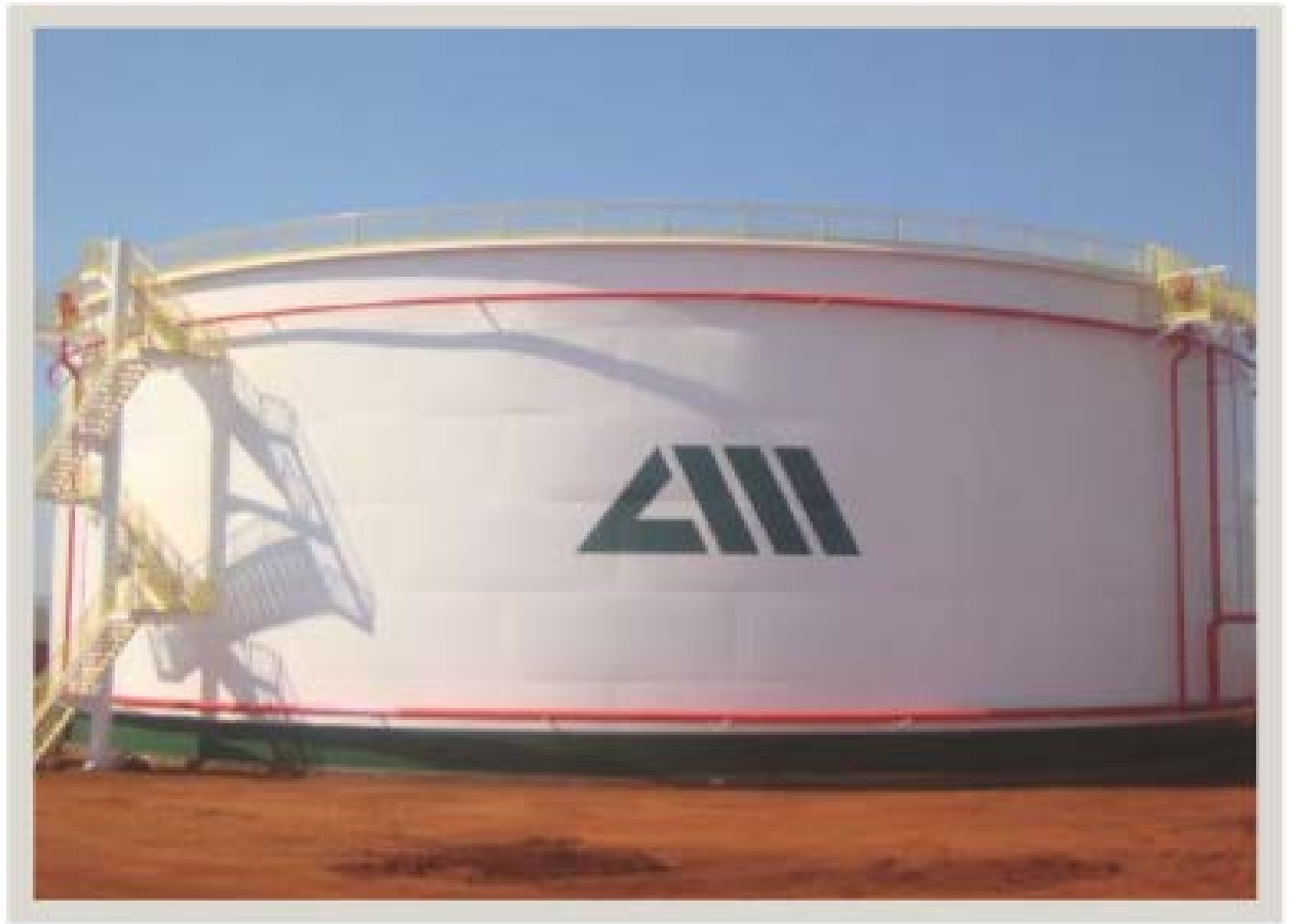
RESERVATÓRIOS DE ETANOL
