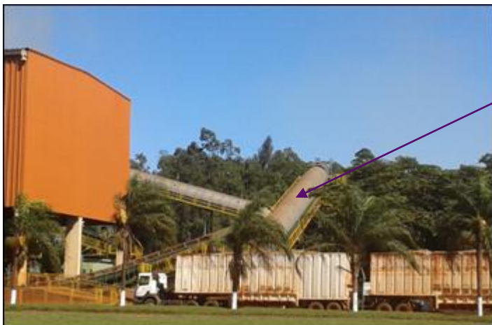
Cobertura - Transportador de Cana (409)
